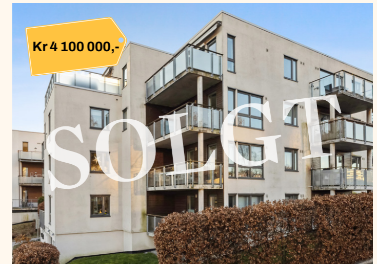
HAUGER: Leilighet i Hauger Skolevei 76 på 46 m2 til 4 100 000, pluss fellesgjeld på 14 634 kroner.
