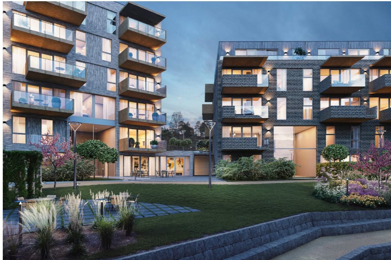
MANGE FELLESAREALER: Alle byggene i Steinsfjorden Terrasse er nå oppført. Til våren starter arbeidet med uteområdene.
